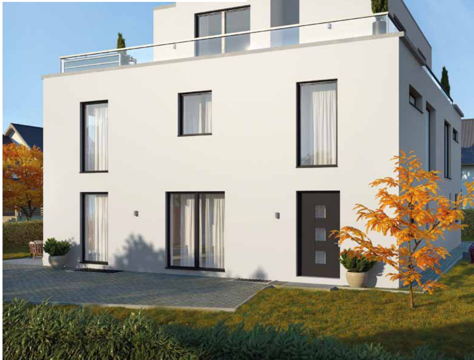
2 Doppelhaushälften in Ottobrunn
